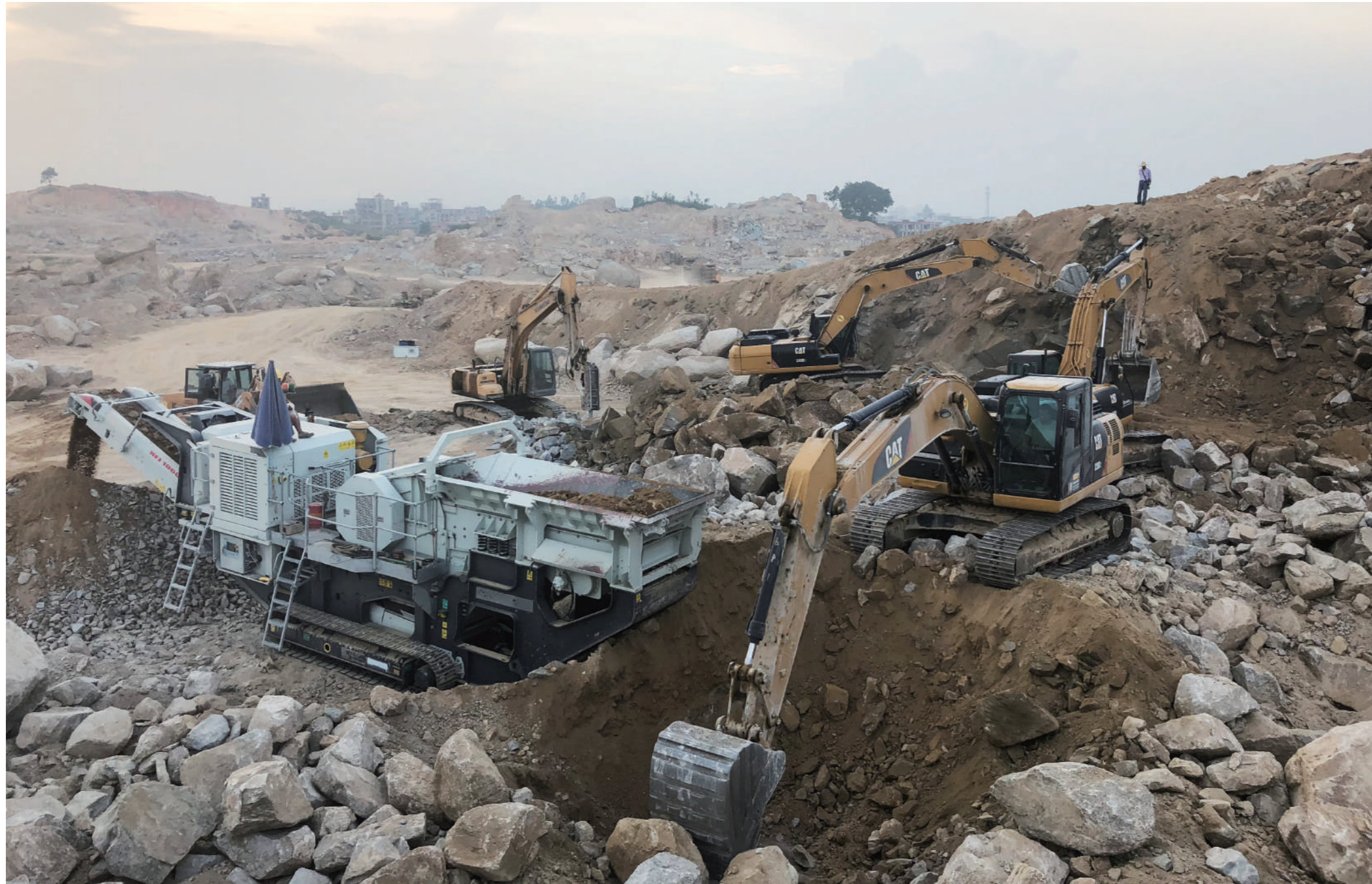
NFJ1060工程回填料破碎应用 NFJ1060 crushing filling material
